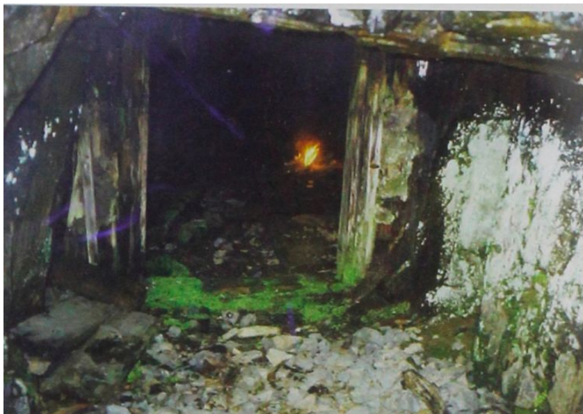
Вход в штольню строившейся электростанции на реке Горин. Снимок 2003 года.
