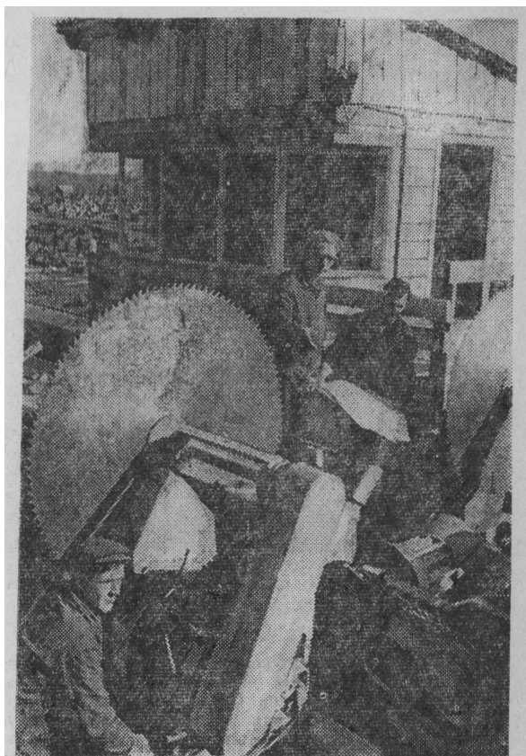
Новая линия полуавтоматической разделки в Вяземском леспромпхозе Фото А. Галушко
