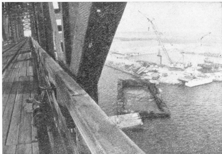
А сейчас на трассе БАМа уже возведены гигантские железнодорожные мосты
